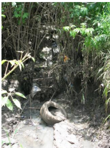
Descarga de aguas residuales sin tratamiento
