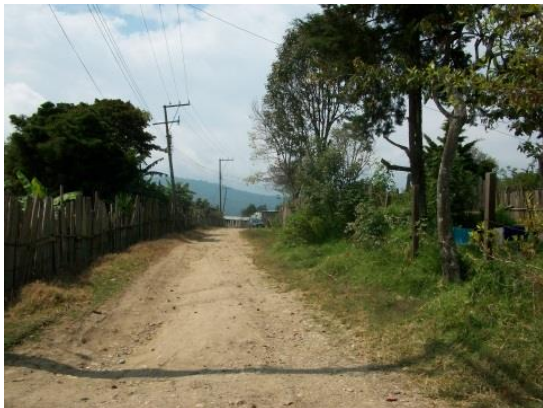
Calle sin concreto
