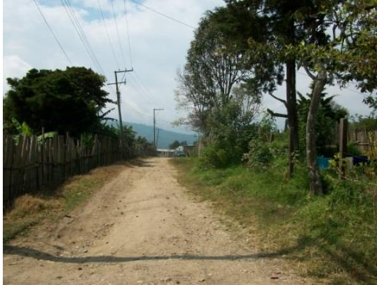
Calle sin concreto
